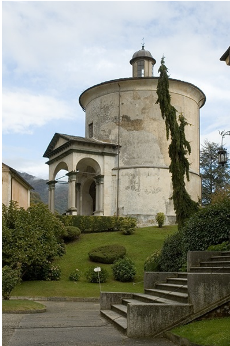
2. El sacro monte en Varallo, en el moderno Piamonte.
